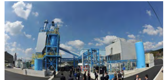
川南町の発電所
